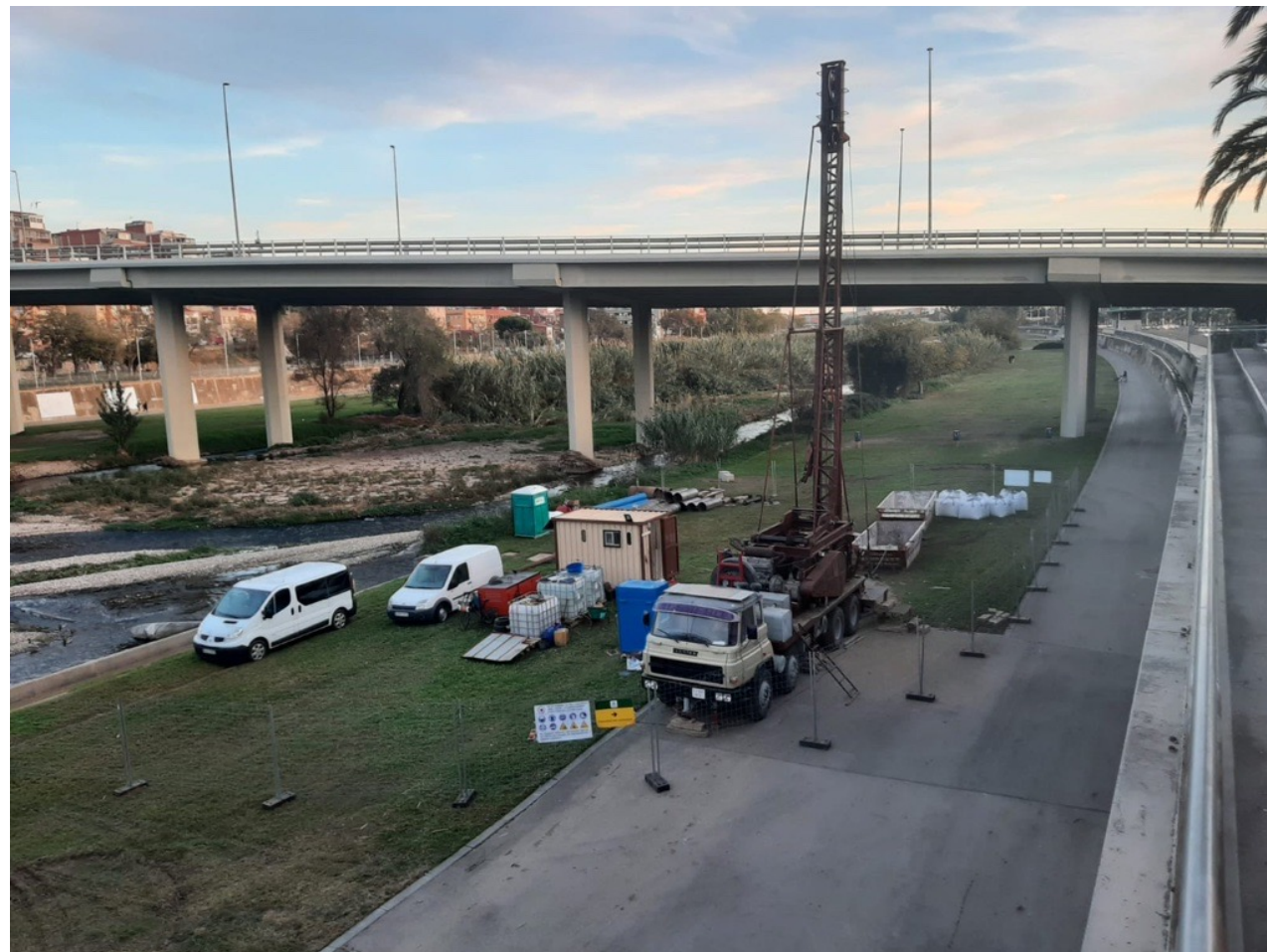
Primer pozo de extracción por recarga inducida de la futura ETAP
