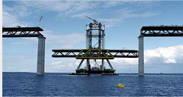
La construction du pont
