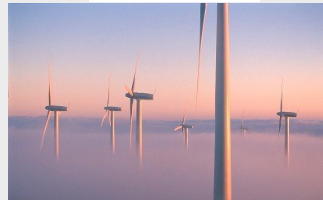
Parc éolien de Middelgrunden
