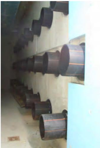
densité nécessaire. Des mesures effectuées après deux ans d'utilisation ont prouvé l'efficacité de ce puits canadien qui permet de préchauffer passivement l'air extérieur de 5°C à 7°C en moyenne. Le volant thermique peut atteindre 12°C les jours les plus froids de l'hiver. Un *by-pass* avec une prise d'air directe court-circuite automatiquement le puits canadien lorsque la température extérieure varie entre 18°C et 20°C.
