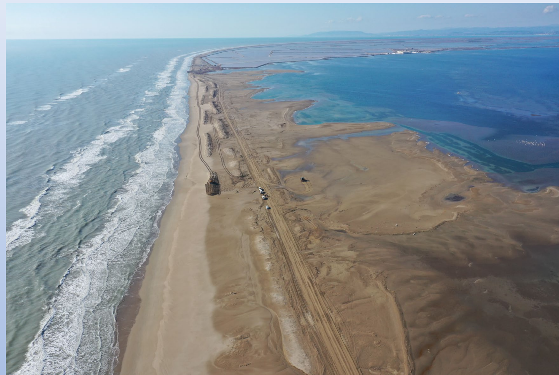
IMAGEN DE LA BARRA DEL TRABUCADOR DEL DIA 10 DE FEBRERO DONDE SE OBSERVA ( Y SE VERIFICÓ EN CAMPO) EL AUMENTO DE COTA EN EL FRENTE LITORAL
