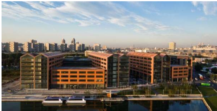
Le parc du Millénaire HQE
