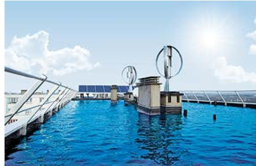
Système permettant à travers le couplage de l'éolien, de l'hydraulique et du solaire, de faire fonctionner de manière autonome en énergie, le réseau de télédistribution, le contrôle d'accès, la VMC et l'éclairage des parties communes des locaux collectifs (cages d'escaliers) :
