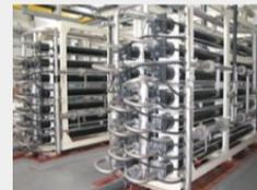
Appareil de nanofiltration (fonctionnant à l'électricité) pour épurer l'eau « potable » avant distribution.
