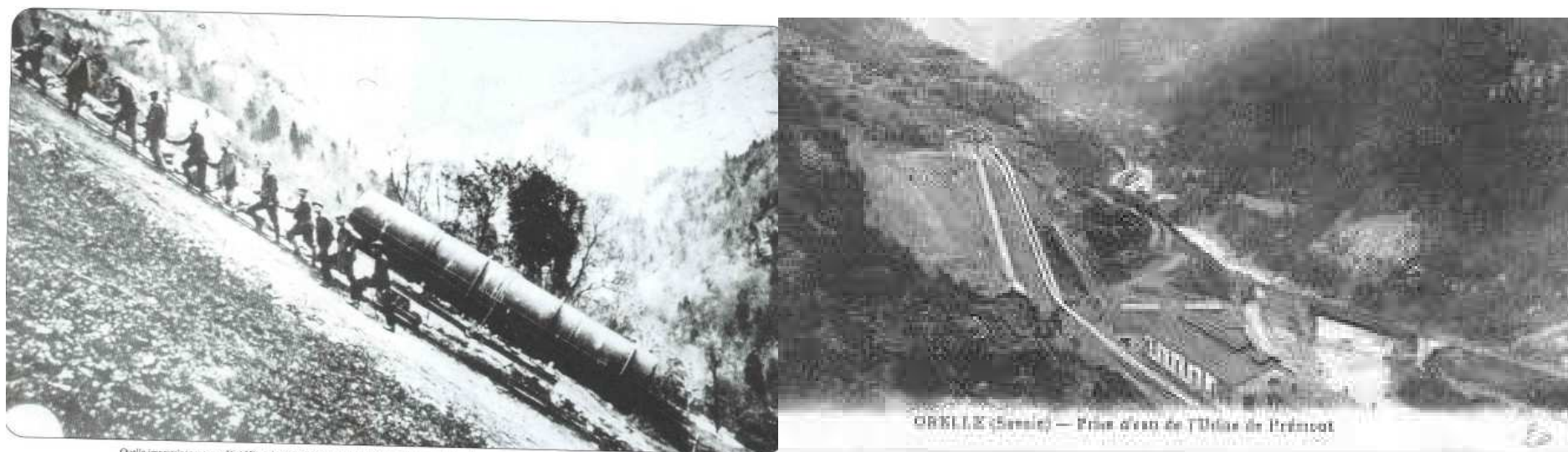
Quelle impressionnante cordée ! Hisser les éléments de la conduite forcée au sommet de la chute sur un terrain aussi escarpé est une tâche ardue.
