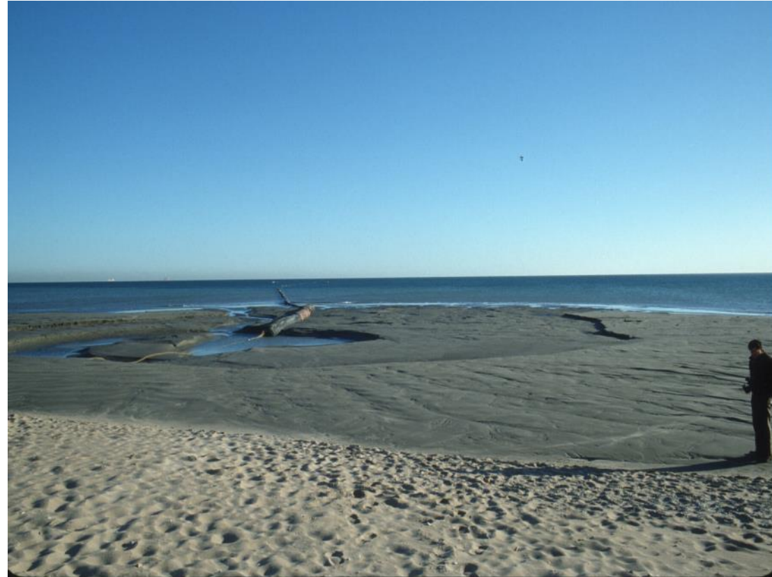
Platja dels Ferros. Año 1990. Aportación artificial de arena muy fina adquirida de la playa sumergida situada al norte del puerto de Valencia extraída con una draga.
