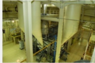
Usine de laine de verre (fonctionne au gaz et à l'électricité).
