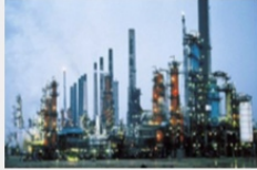
Vapocraqueur (fonctionnant au gaz et à l'électricité) pour fabriquer les composants de base des matières plastiques à partir de produits pétroliers ou de gaz.
