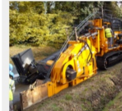
Excavatrice de tranchée (fonctionne au pétrole) pour faire passer les câbles.
