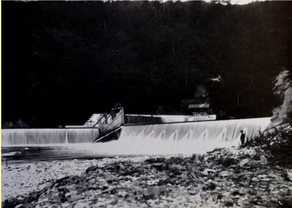
Centrale hydroélectrique de Brassily
